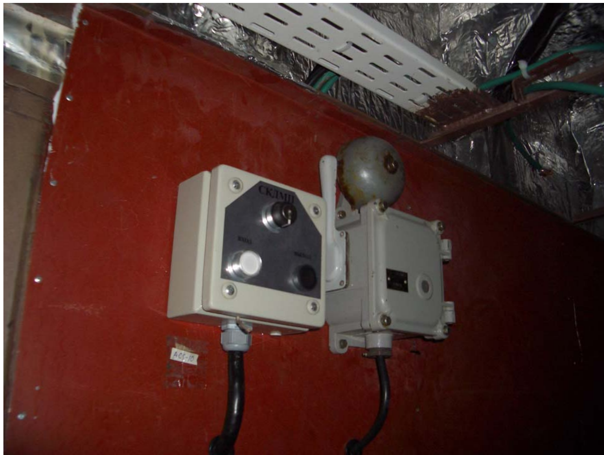
Рис. 2 Блок управления системы сигнализации контроля дееспособности машинного персонала (СКДМП)
