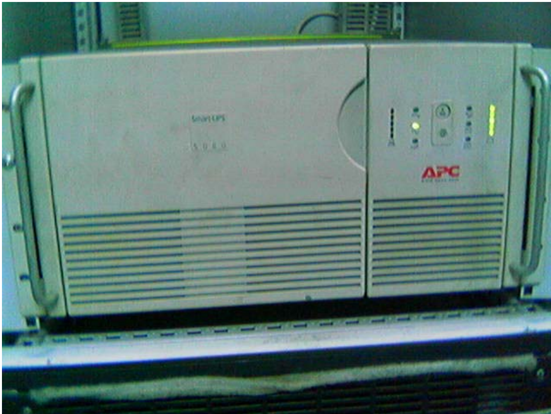
Рис. 7 Шкаф ИБП
